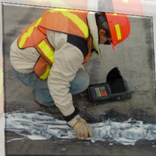
Неразрушающий контроль сварных швов ультразвуком
