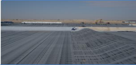
РЕЗЕРВУАР, АЛЖИР — 280 000 м²
